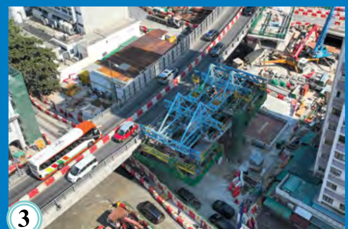
3 加士居道天橋重置工程 Reprovisioning of Gascoigne Road Flyover
