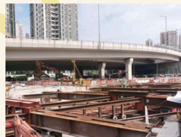
明挖回填隧道工程 Construction of cut-and-cover tunnel
