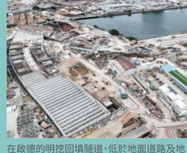
在啟德的明挖回填隧道、低於地面道路及地下行車道工程 Construction of cut-and-cover tunnel, depressed road and underpass at Kai Tak
