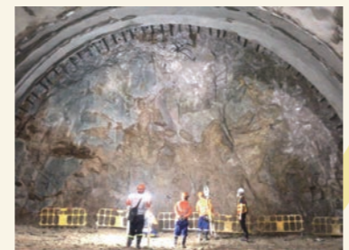
隧道挖掘工程 Tunneling Works
