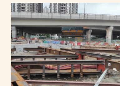
明挖回填隧道工程 Construction of cut-and-cover tunnel
