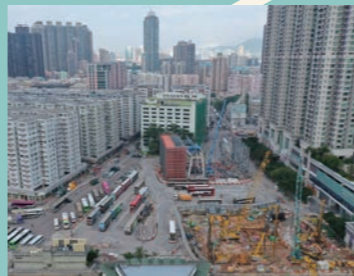
在馬頭角的「連續式互扣式管樁」安裝工程 Installation of "clutch pipe pile" for cut-and-cover tunnel
