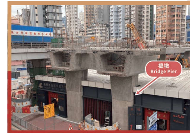
安裝移動模板前的重置加士居道天橋 RGRF before installation of Form Traveller
