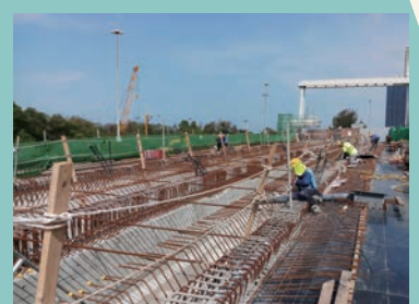
連接橋的橋面建造工程 Deck construction of connection bridges
