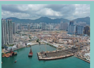
在九龍灣的第一期及第二期海底隧道工程 Construction of Stage 1 & Stage 2 Underwater Tunnel at Kowloon Bay
