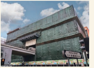
油麻地停車場大廈拆卸工程 Demolition of Yau Ma Tei Carpark Building
