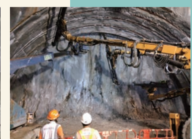
馬頭角隧道掘進工程 Tunneling works at Ma Tau Kok
