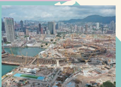
在啟德的明挖回填隧道、低於地面道路及地下行車道工程 Construction of cut-and-cover tunnel, depressed road and underpass at Kai Tak
