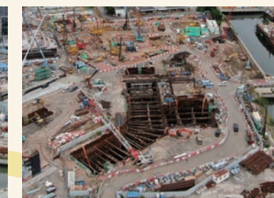
地下行車道及通風坑道建造工程 Construction of underpass and ventilation adit
