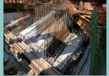
通風坑道的建造工程 Construction of ventilation adit
