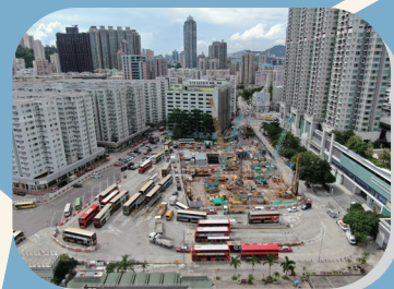
在馬頭角的豎井通道及明挖回填隧道工程 Construction of access shaft & cut-and-cover tunnel at Ma Tau Kok
