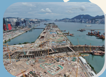
在啟德的明挖回填隧道、低於地面道路及地下行車道工程 Construction of cut-and-cover tunnel, depressed road and underpass at Kai Tak
