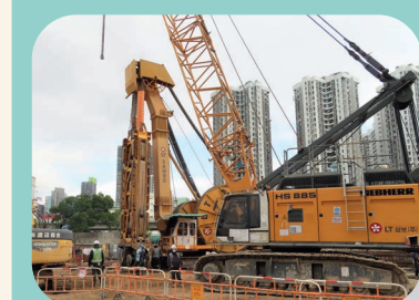
低於地面道路隔牆建造工程 Diaphragm wall construction works for depressed road
