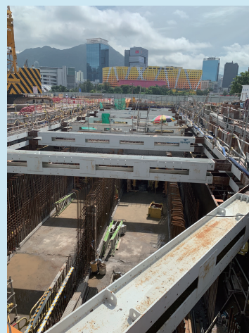
啟德部份地下通風坑道的建造工程 Construction of part of underground ventilation adit at Kai Tak
