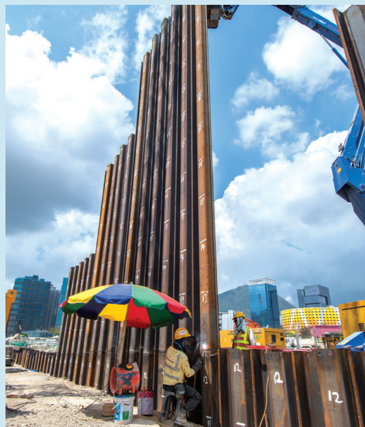
位於啟德發展區的工地，臨時板樁工程已於2018年第二季展開，以便進行挖掘與橫向承托工程 Construction of temporary sheet piling works for Excavation and Lateral Support (ELS) at Kai Tak works area commenced in the 2 nd quarter of 2018
