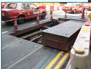
覆蓋在地下進行的隧道工程 Covering the underground construction works
