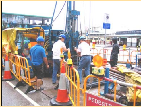
鑽探儀器 Drilling Machine
