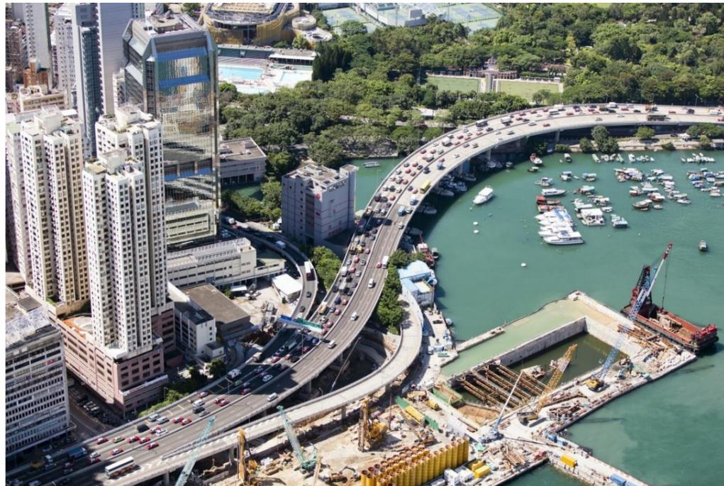
圖 3-14 - 臨時填海配合明挖回填法的例子
