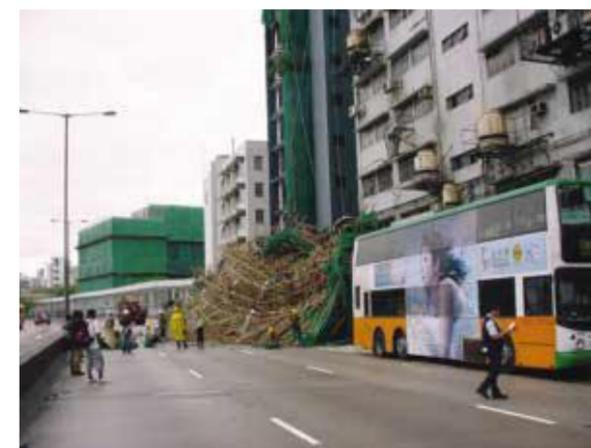
圖 2-4 - 2005 年 5 月 9 日在太子道東發生的棚架倒塌事故
