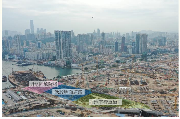
啟德的明挖回填隧道、低於地面道路及地下行車道工程
