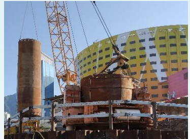
啟祥道掉頭支路的行車天橋鑽孔樁工程
