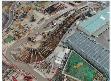
地下行車道的挖掘及橫向支撐安裝工程
