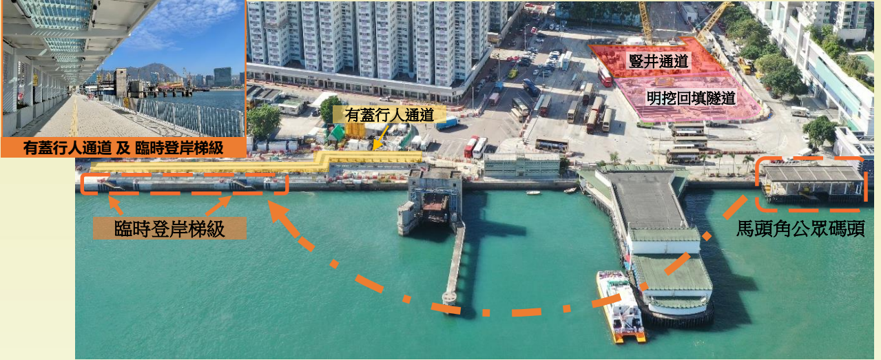
馬頭角的豎井通道、明挖回填隧道、景雲街的臨時登岸梯級及有蓋行人通道建造工程
