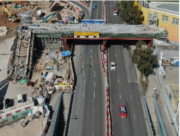
啟福道行人天橋的橋面、樓梯及升降機槽建造工程正在進行中。
