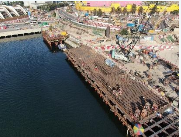
橫跨啟德河的行車天橋臨時工作平台搭建工程
