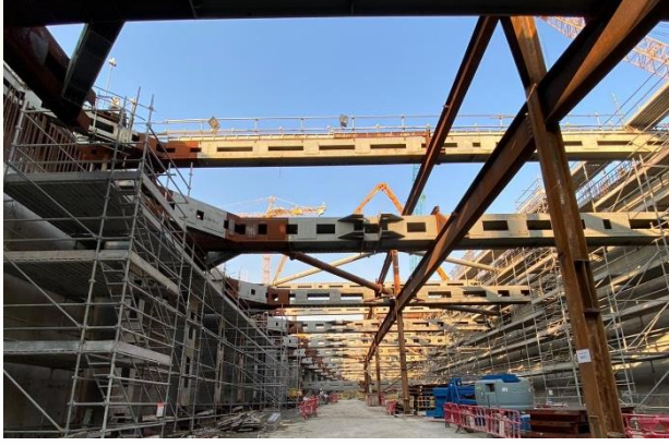
地下行車道的結構牆建造工程
