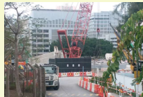
安裝隔音屏障
