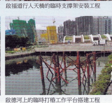
啟德河上的臨時打樁工作平台搭建工程
