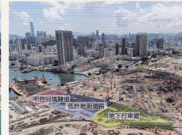
啟德的明挖回填隧道、低於地面道路及地下行車道工程
