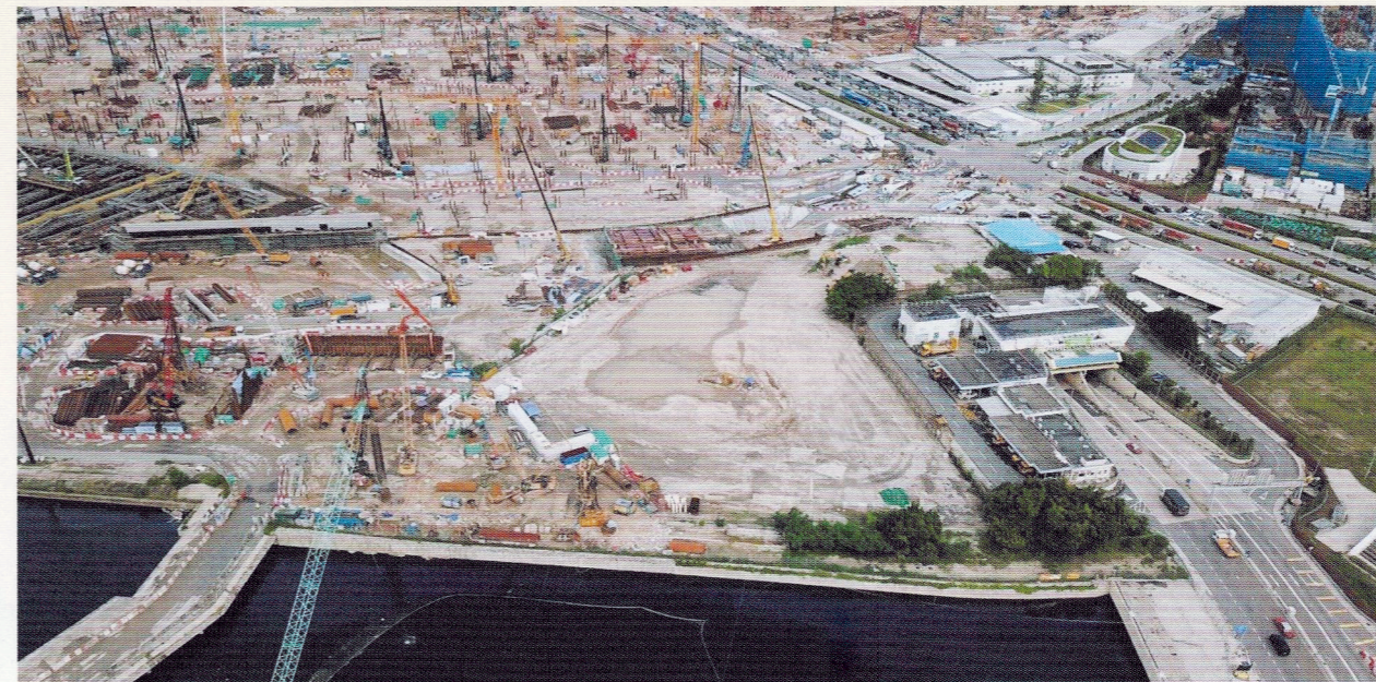
啟德通風大樓及行政大樓工地
