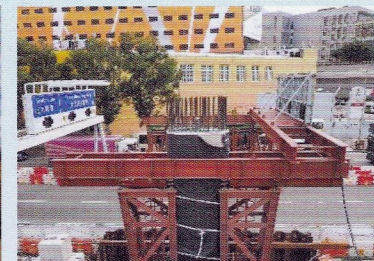
啟福道行人天橋的臨時支撐架安裝工程
