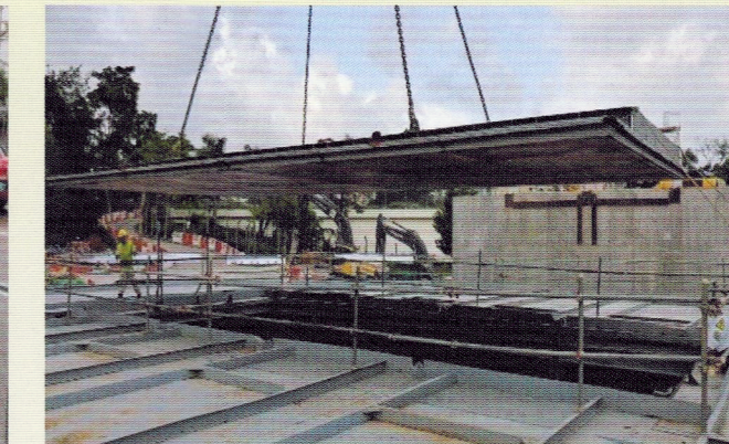
於爆破前覆蓋豎井隔音罩
