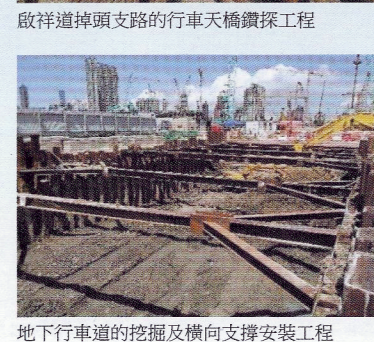
地下行車道的挖掘及橫向支撐安裝工程
