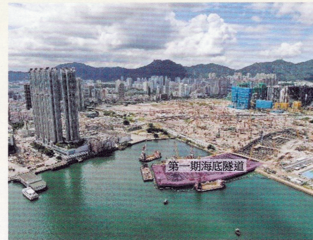
九龍灣的第一期海底隧道工程
