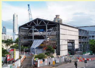
安裝隔音屏障
