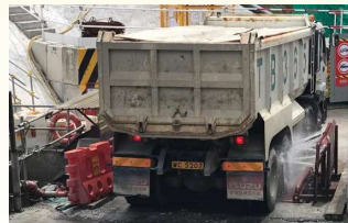
工地出口設有自動清洗運泥車車輪設施及用隔塵布完全覆蓋物料
