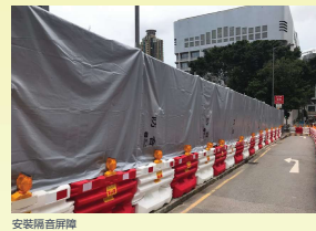
安裝隔音屏障
