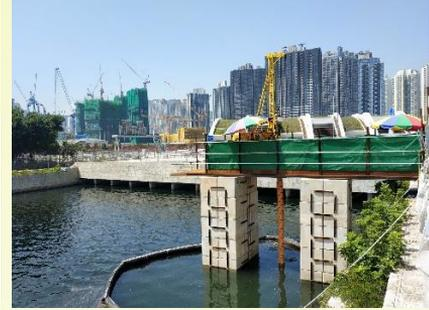
啟德河的行車天橋鑽探工程
