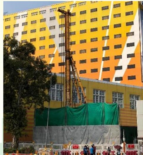
工地懸掛設有隔音作用的隔音布
