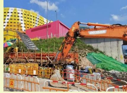
啟祥道掉頭支路的行車天橋鑽探工程
