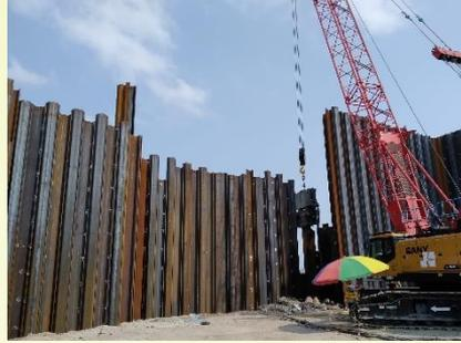
地下行車道的板樁工程
