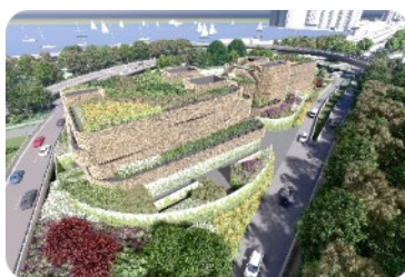
2. 油麻地通風大樓
