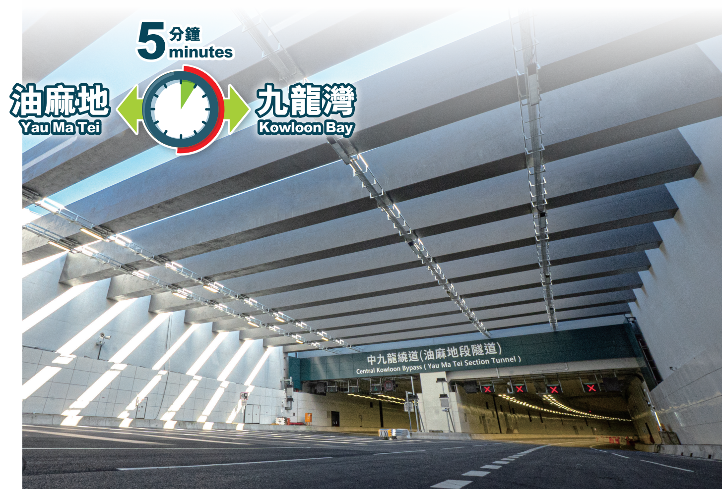
東面隧道出入口 Eastern Tunnel Portal
