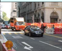
漢口道地底工程 Underground construction works in Hankow Road
