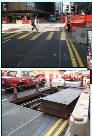
覆蓋在地底進行的隧道工程 Covering the underground construction works
