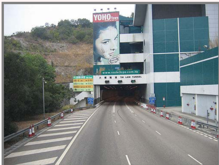
大欖隧道 Tai Lam Tunnel
