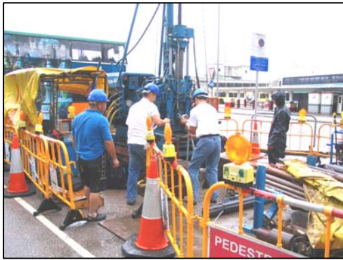
鑽探儀器 Drilling Machine
